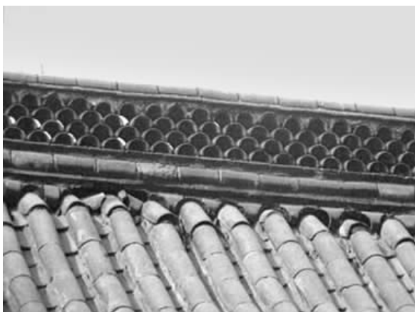
图二 西楼正脊两侧的瓦件错位、脱节现状
