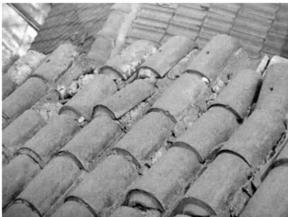
图一 东楼后坡屋面筒瓦残损现状
