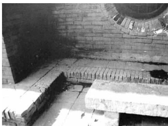
图五 院内台明用机砖临时砌筑现状
