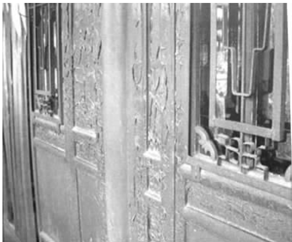
图七 装修油漆起翘、脱落现状
