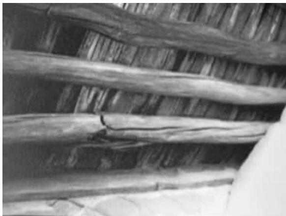
图四 北楼东山出际部位的椽子折断现状
