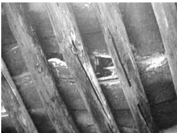
图三 北楼前檐椽子劈裂、望板局部塌陷现状
