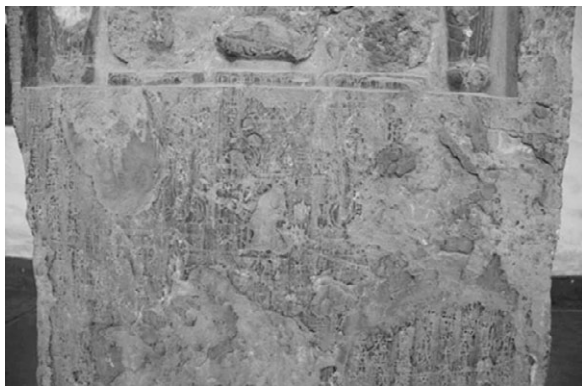
图六 石碑显示出的层状剥落情况
