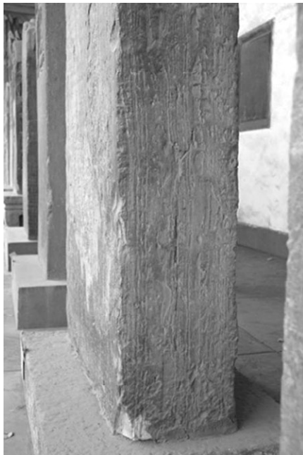
图二 石碑侧面显示出石材的层状分布
