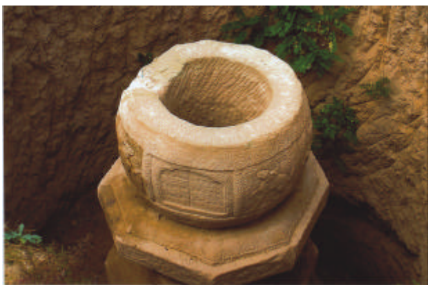
图4 塔的主体部分凿成空心
