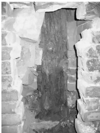
图五 山墙柱根探洞
