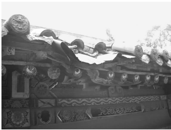
图八 檐口破损
