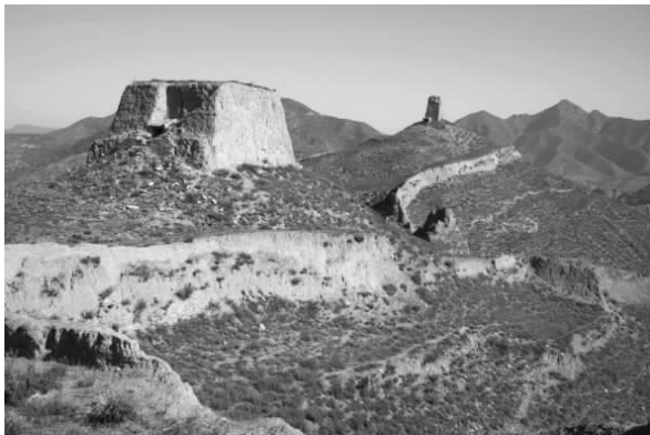
图五 繁峙西跑池长城铲削墙
