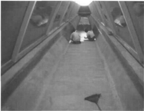
图五// 二号坑玻璃钢的铺设
