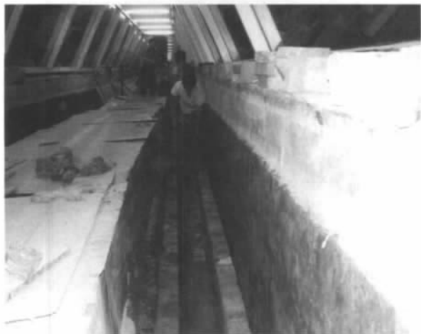
图四// 徐州楚王陵墓坑底砌筑排水盲沟
