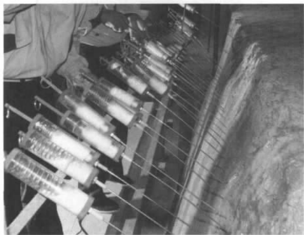
图十二// 压力注射法加固中层封土
