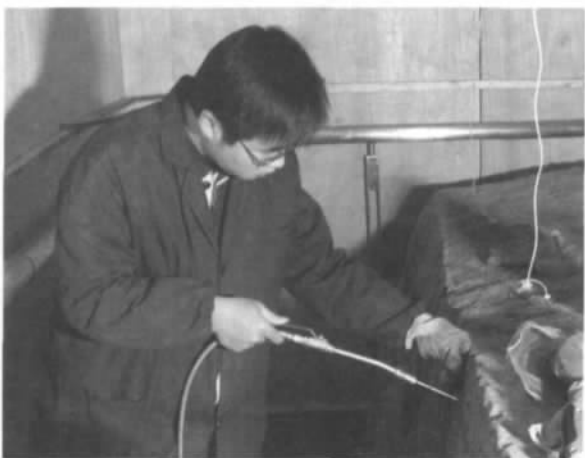
图十一// 注浆法加固封土里层封土
