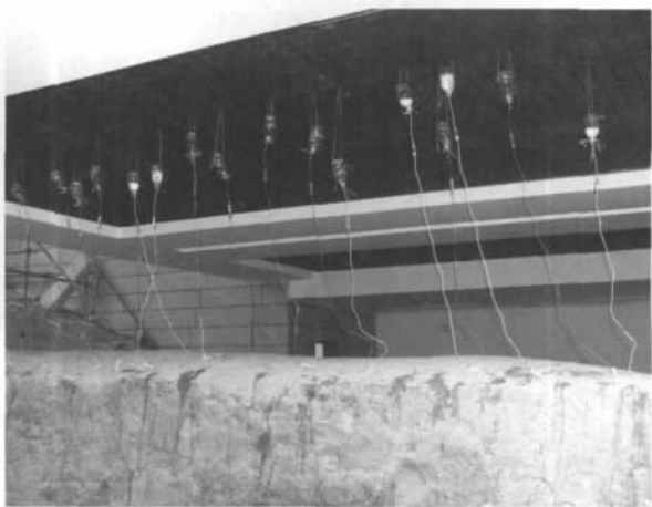
图十三// 滴挂法加固外层封土
