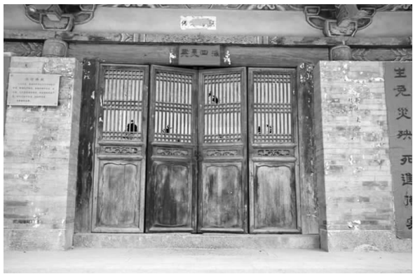
图五 燃灯佛殿现存四抹隔扇门
