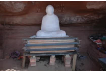
图 14 单边托换分离 Fig. 14 Separated one side
