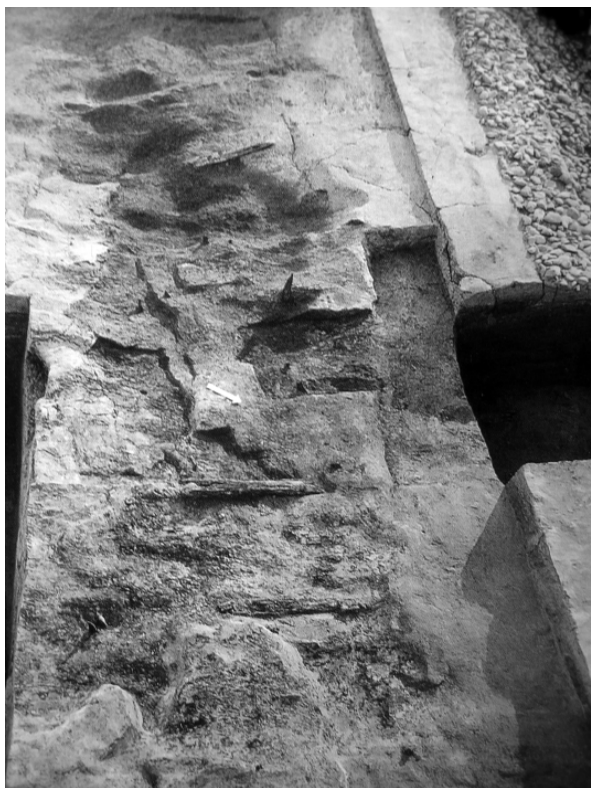
图四// 风纳土城筑造所用的散草法
