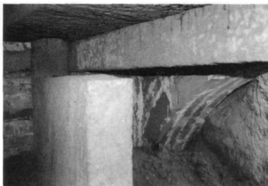
图七 明肃庄王玄宫前室石门结构
