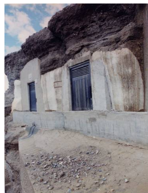
图 6 洞窟 C193 附近强风化砾岩雨后掉落现象
