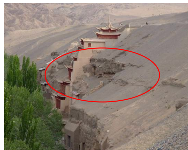
图 5 莫高窟崖顶缓坡砂岩差异风化现象
